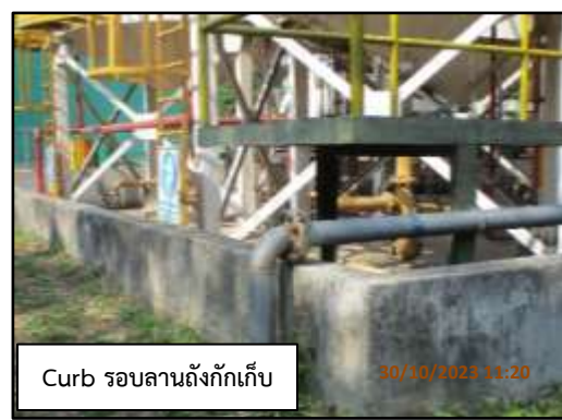
ภาพที่ 2.41 ปัม และ Bund Wall รอบถังกักเก็บ Liquid Waste
