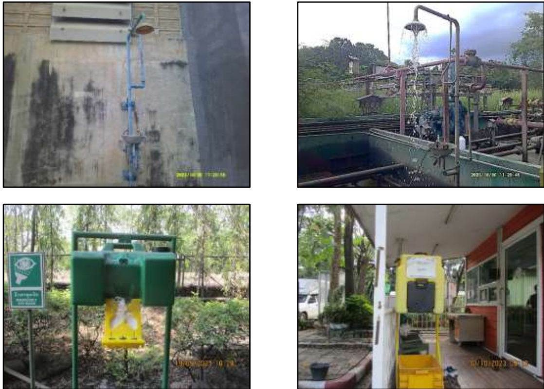
ภาพที่ 2.51 ฝักบัวฉุกเฉินและอ่างล้างตาฉุกเฉินภายในพื้นที่โครงการ
