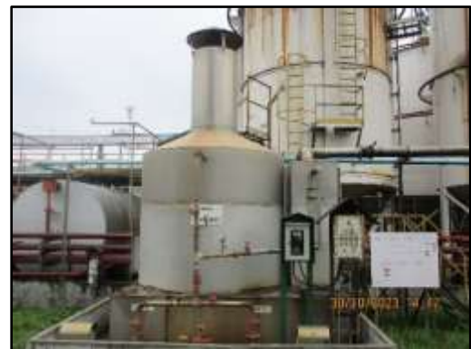
ภาพที่ 2.7 ระบบบำบัดไอสารอินทรีย์โดยใช้ Bio Filter สำหรับถังเก็บ Liquid Waste
