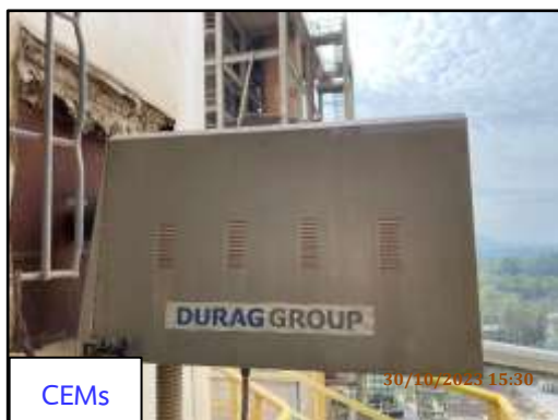
ภาพที่ 2.5 เครื่องตรวจวัดคุณภาพอากาศแบบต่อเนื่อง (CEMs) และระบบ Gas Analyzer ที่ปล่องหม้อเผา
