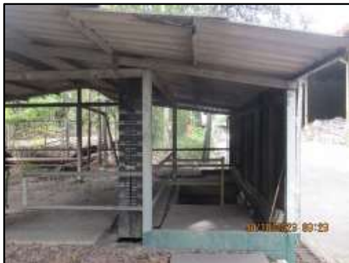
ภาพที่ 2.49 รางระบายน้ำและบ่อดักไขมันเฉพาะอาคารจัดเก็บ Solid Waste
