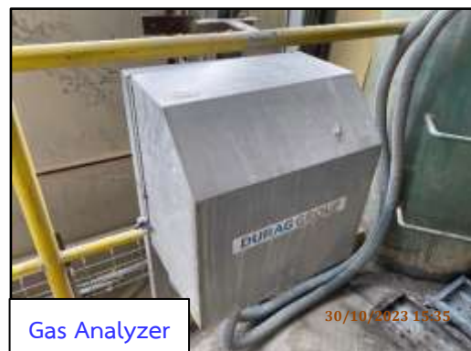
ภาพที่ 2.5 เครื่องตรวจวัดคุณภาพอากาศแบบต่อเนื่อง (CEMs) และระบบ Gas Analyzer ที่ปล่องหม้อเผา
