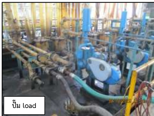
ภาพที่ 2.41 ปัม และ Bund Wall รอบถังกักเก็บ Liquid Waste
