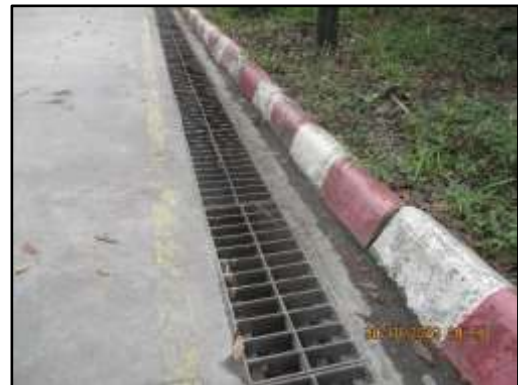
ภาพที่ 2.49 รางระบายน้ำและบ่อดักไขมันเฉพาะอาคารจัดเก็บ Solid Waste
